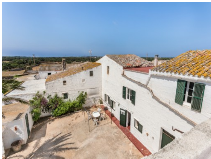
Azotea con vistas panorámicas
