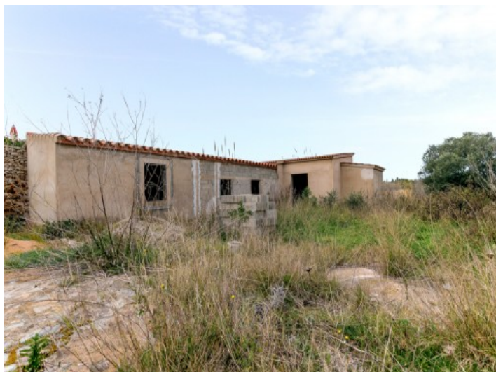
Vista alternativa del terreno
