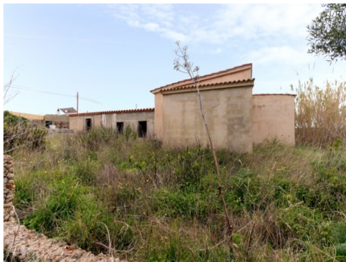
Vista alternativa del terreno
