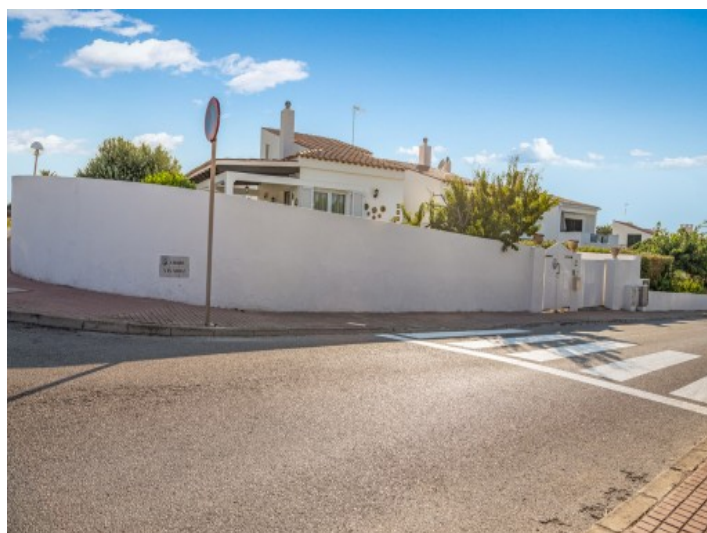
Vista exterior del chalet
